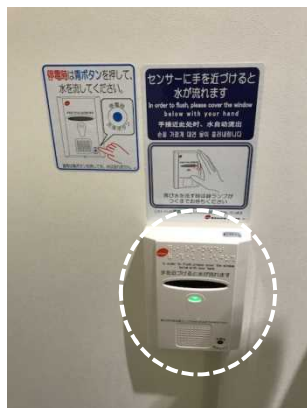
<自動洗浄装置の設置>
