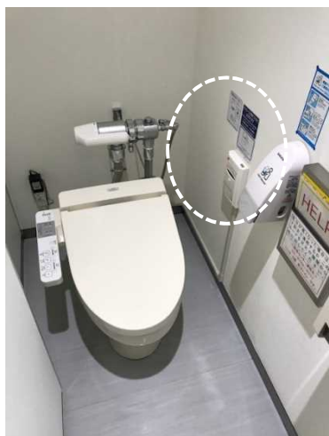
<自動洗浄装置の設置>
