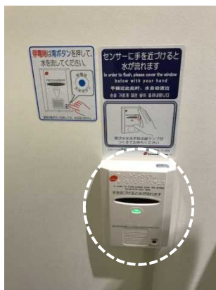
<自動洗浄装置の設置>
